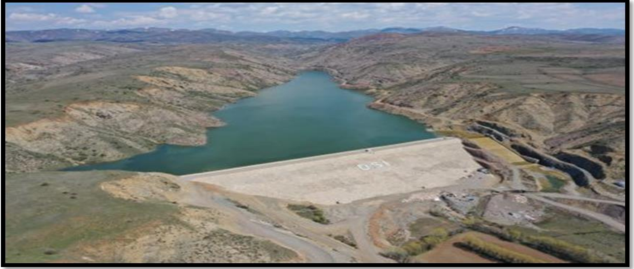
Foto 5. Akören Kuşçu Barajı
