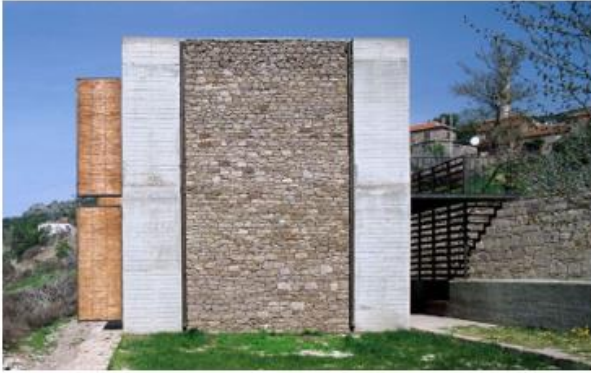
Fot. 2 Betonarme Bant (EMDEN)
