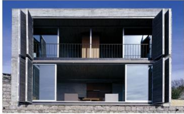
Fot. 3 Betonarme Bant (EMDEN)
